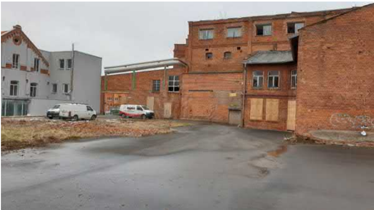
Abbildung 13 westlicher Geltungsbereich Blickrichtung Nordost
