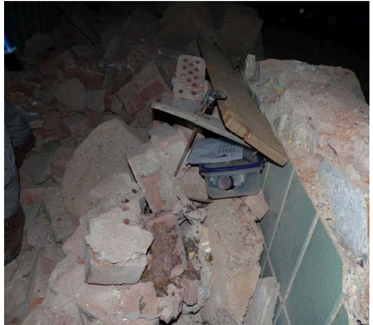
Abb. 3: Anabagerät im Keller-Durchgang zwischen Hangplatz-Spalte und möglichem Ausflug an der Böschung.
