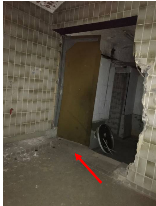
Abb. 11: Weiterer Türdurchgang in großer Halle unter der viel Kot lag, aber keine Zwergfledermäuse im Tür-Spalt gefunden wurden.
