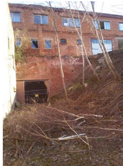
Abb. 19: Große Einflugmöglichkeit in den westlichen Kellerabschnitt unterhalb der ehem. Pferdeställe.
