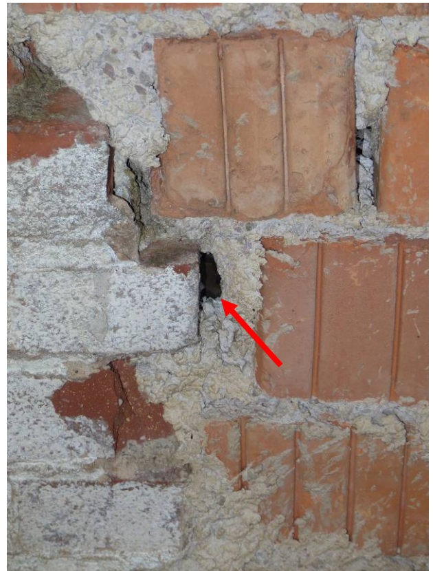
Abb. 9: Einzelne Zwergfledermaus in Backsteinfuge im westlichen Kellerabschnitt
