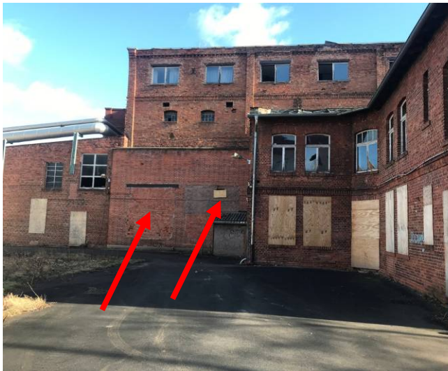
Abb. 18: Beide Ziegel-Doppelwände von außen am Westzugang des Gebäudekomplexes.
