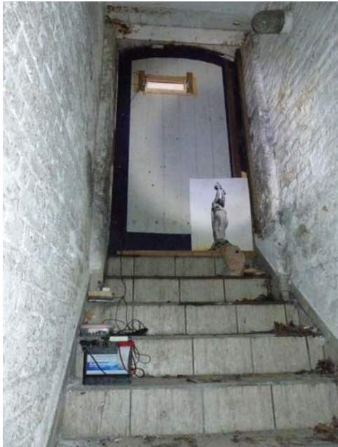
Abb. 2: Installiertes Lichtschrankensystem Liba 4 und Aktivitätssensor NODEC sowie Tricorder inkl. Temperaturmessung der Fa. ChiroTEC am Kellerausgang Robert-Koch-Str.
