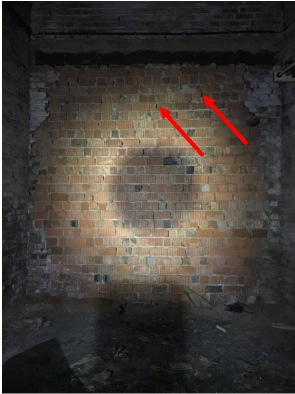
Abb. 14: Ziegelwand (Backsteinwand) Keller unter ehem. Pferdeställen mit zahlreichen Fugenspalten, in denen 2 Zwergfledermäuse überwintern (rote Pfeile = Hangplätze).
