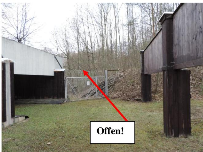
Zur Dämpfung des Mündungsknalls wäre eine Überdachung des ersten Schießbahnenbereiches bis über die 1. Hochblende hinausgehend und anbindend an das Dach des Schützenhauses sinnvoll. Das verlängerte Dach müsste schalldicht an die beiden Seitenwände anbinden und ein Bauschalldämm-Maß von  $R_w \geq 25$  dB besitzen. Sämtliche Innenwände und die Dachinnenseite müssen schallabsorbierend verkleidet werden.
