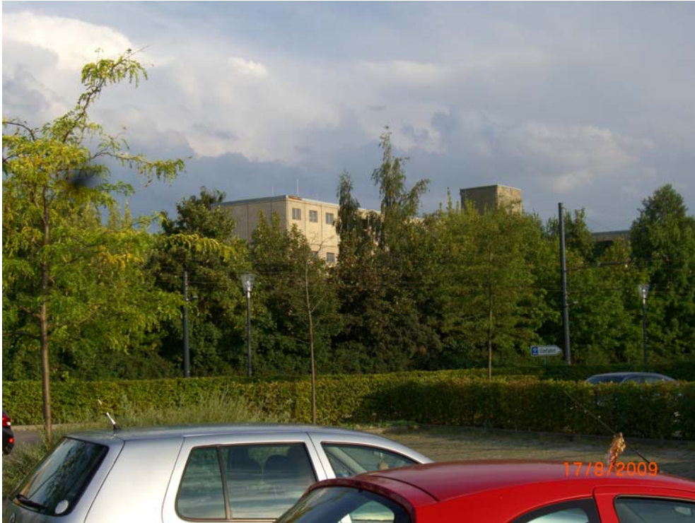
Abb. 1: Blick auf das ehemalige Schulgebäude und das Umfeld vom Gelände des Katholischen Krankenhauses Erfurt aus (17. August 2009; Foto: J. Weipert)
