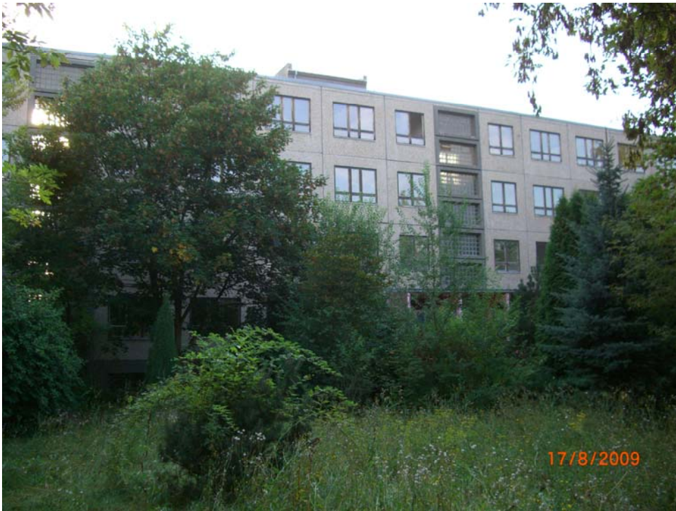
Abb. 3: Die Fassade des Schulgebäudes und das Umfeld auf der Ostseite (17. August 2009; Foto: J. Weipert)
