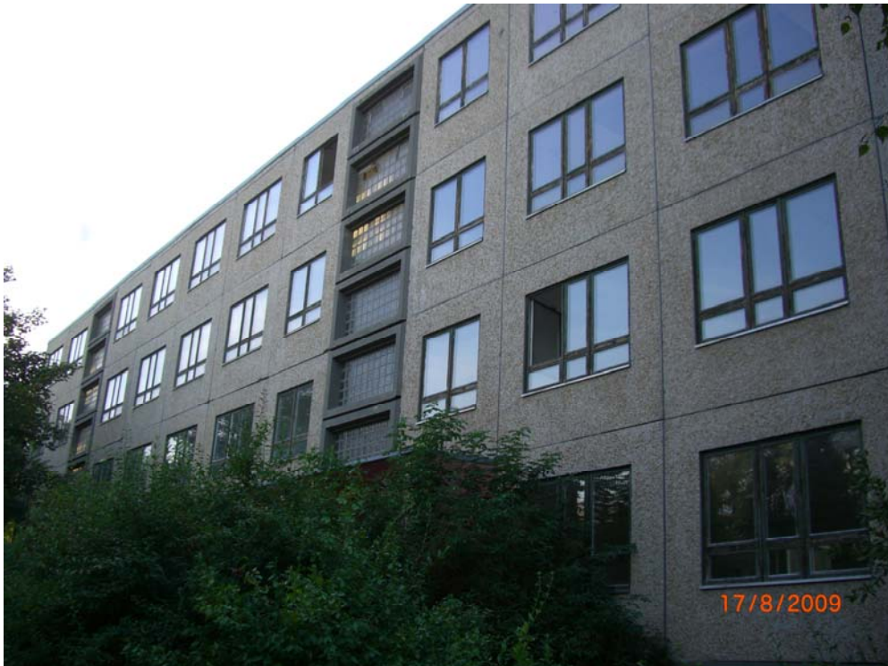
Abb. 2: Die östliche Fassade des Schulgebäudes (17. August 2009; Foto: J. Weipert)
