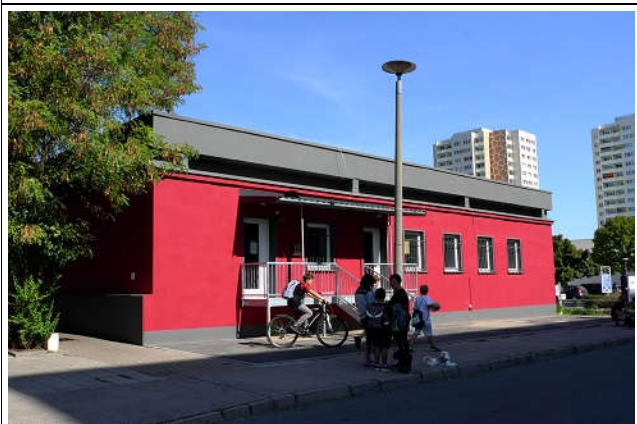
Abb. 6: An der Südeite gelegenes Einzelgebäude
