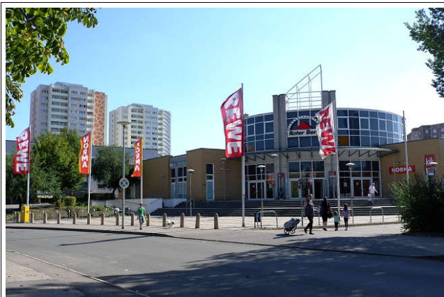
Abb. 2: Einkaufszentrum Roter Berg Nordseite
