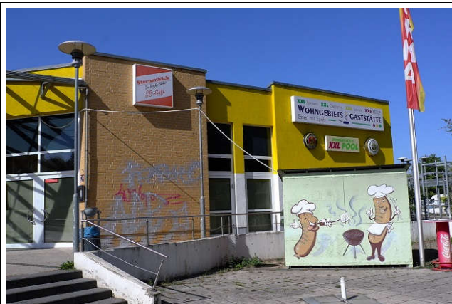
Abb. 3: Teilansicht der westlichen Fassade
