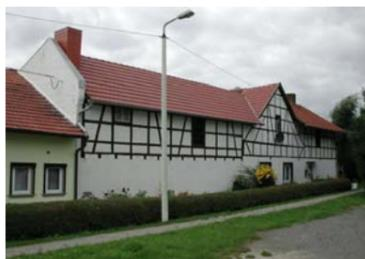
Wand- und Fassadenkonstruktion als Holzfachwerk, aus Ziegelmauerwerk, verkleidet bzw. verputzt
