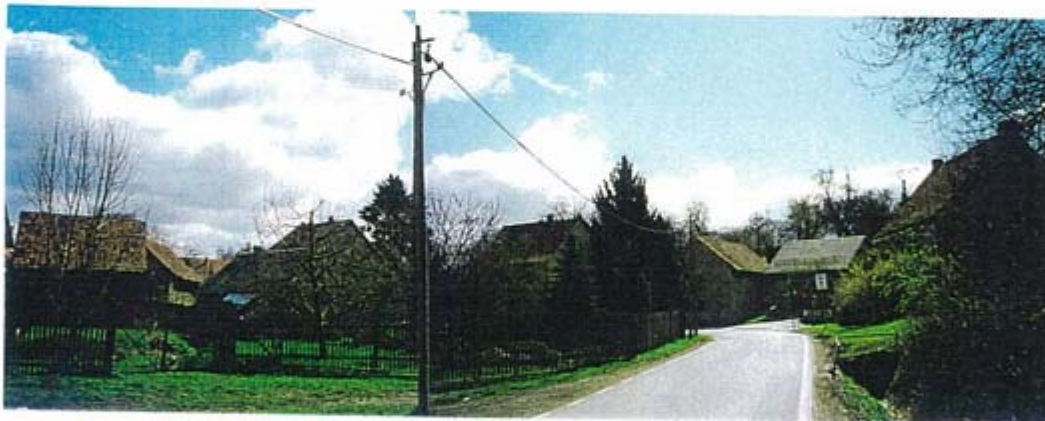
Abb. 41 Ortseingang Rohda (von Niedernissa)
