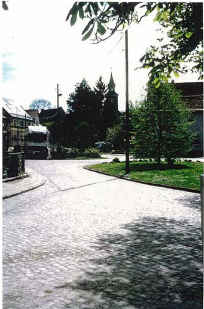
Abb. 23 Natursteinpflaster - lebendig und durchlässig am Anger in Rohda
