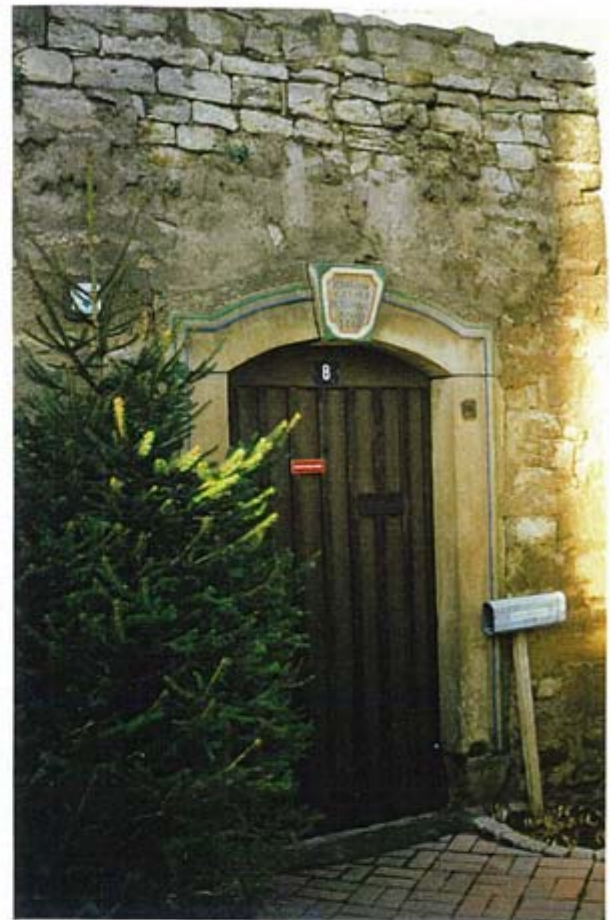
Abb. 16 Schöne Türanlage in Niedernissa, Am Anger Nr. 8
