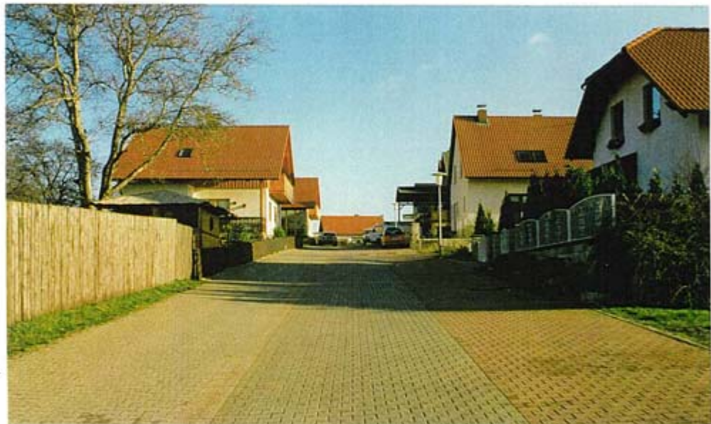
Abb. 21 Versiegelung mit Betonstein-Verbund- pflaster „In der Trift“ in Niedernissa
