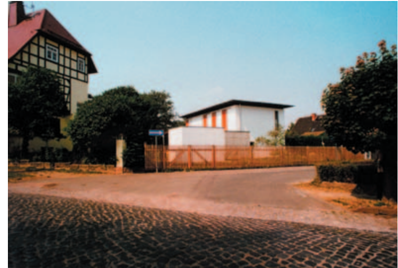
Abb. 31 Ecke Bahnhofstraße / Fasanerieweg
