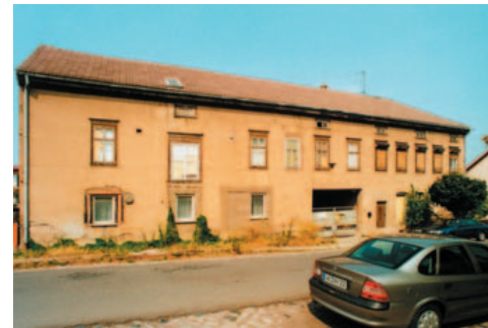
Abb. 15 Leerstehendes Gebäude Bahnhofstraße 30
