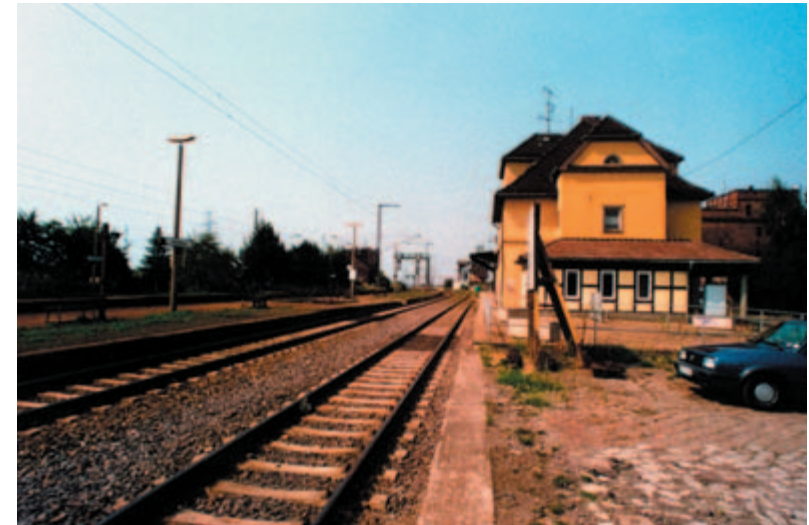
Abb. 28 Gleise in Richtung Erfurt, rechts Bahnhofsgelände
