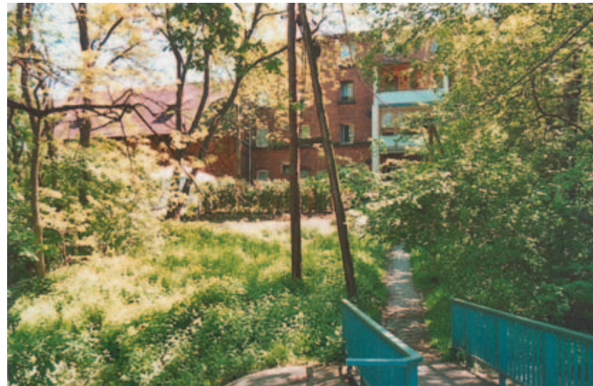
Abb. 5 Fußgängerbrücke über den Vieselbach
