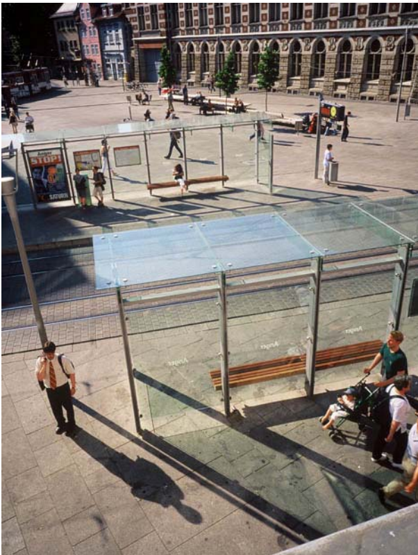
Warteüberdachung Anger 1. BA
