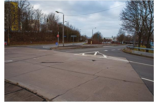
Verkehrsflächen auf dem sanierungsbedürftigen Brückenbauwerk Kranichfelder Straße, Haarbergstraße, Am Wiesenhügel. Breite Flächen für den Autoverkehr. Es fehlen Fahrrad- und Fußwege und Querungsmöglichkeiten.
