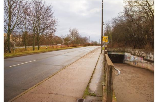
Zugang zur Haltestelle „Abzw. Wiesenhügel“. Der Tunnelzugang ist eine Angsträum.
