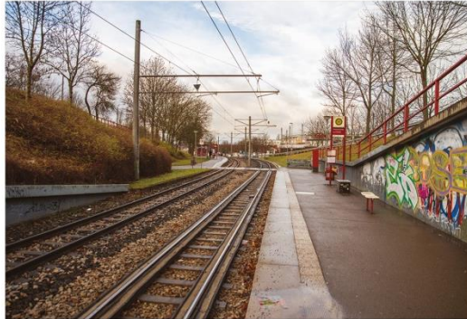
Haltestelle Abzw. Wiesenhügel. Durch die Tieflage und räumliche Abgrenzung ist sie wenig einsehbar.
