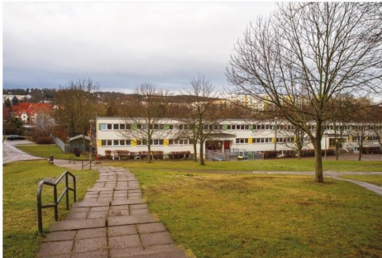
Blick auf die Kita von Norden. Gestaltung Am Sibichen ohne Aufenthaltsqualität und nicht barrierefrei. Die Kita zerteilt die Freiräume in Teilstücke, die einzeln kaum nutzbar sind.
