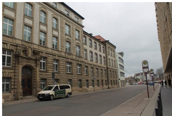
Blick vom IC-Hotel in die Kurt-Schumacher-Straße auf die sanierte Fahrkartendruckerei
