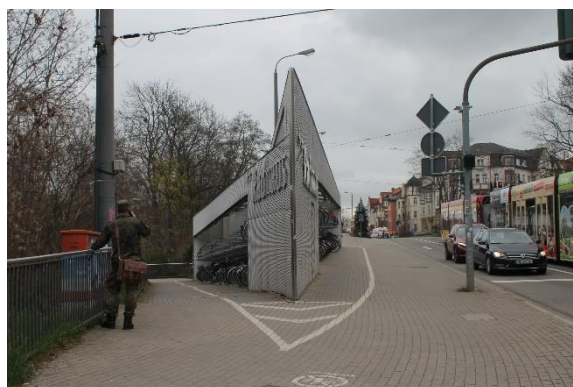
Blick von der Schillerstraße nach Osten auf die neu errichtete Fahrradstation Süd – “Radhaus Süd” - 2021
