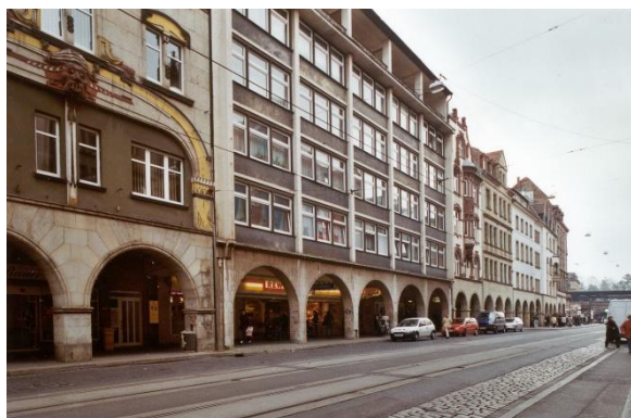
Blick nach Süd-Osten auf die Arkaden vor der Sanierung
