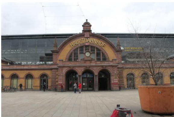
Blick auf den Haupteingang des Vorempfangsgebäudes 2021
