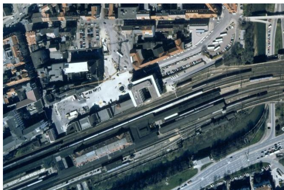
Luftbild vom "Alten" Bahnhof unmittelbar nach Fertigstellung der TGA unter dem Willy-Brand-Platz
