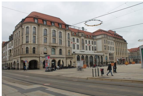
Blick von der Eisenbahnüberführung auf den komplett sanierten und umgebauten ehemaligen „Erfurter Hof“
