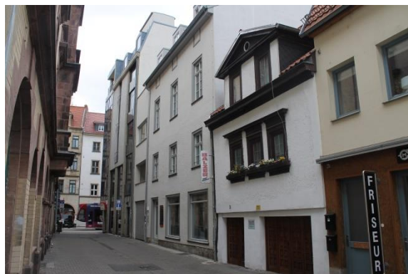
Im Zusammenhang mit der Sanierung wurde auch die Baulücke der Thomasstraße Nr. geschlossen.
