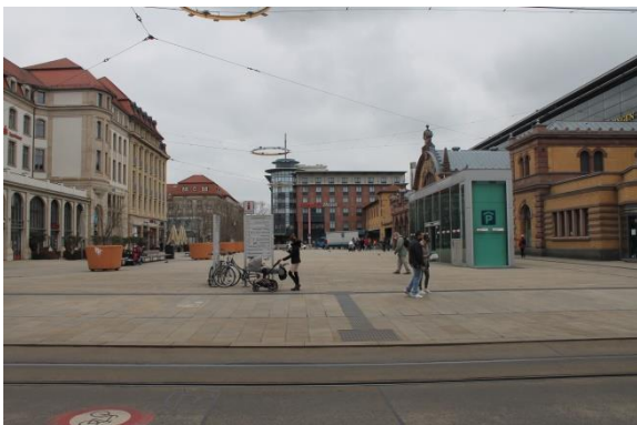
Blick über den Willy-Brandt-Platz nach Osten auf das Eingangsbauwerk der Tiefgarage einschließlich Aufzug und Entrauchungsanlage
