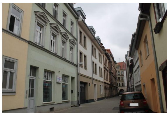
Die Baulücke wurde mit dem Neubau geschlossen. Durch die Verlagerung der Zufahrt sind Störungen des Bahnbetriebs der EVAG im Bereich der Sonntagsgasse minimiert.
