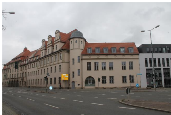
Blick vom Juri-Gagarin-Ring auf das ehemalige Zollamt nach Sanierung und Umbau zum Bürgeramt
