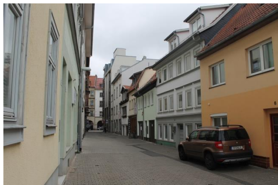
Baulicher Gesamteindruck und Zustand im Bereich der Thomasstraße – mangelhaft und sanierungsbedürftig
