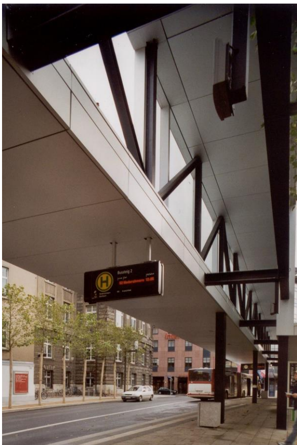
Blick in Richtung IC-Hotel unter die östliche Haltestellenüberdachung
