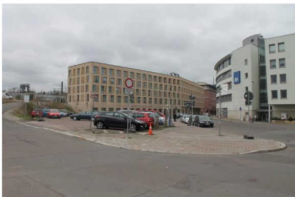
Blick vom künftigen „Promenadendeck“ nach Süd-Westen auf den Hotelneubau „prizotel“
