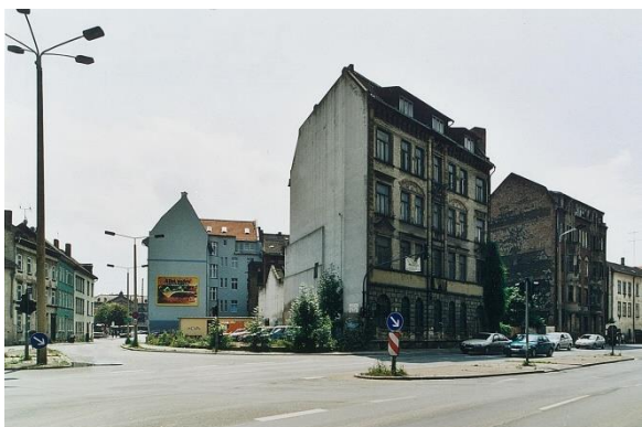
Blick vom Juri-Gagarin-Ring auf die Baulücke an der Bürgermeister-Wagner-Straße
