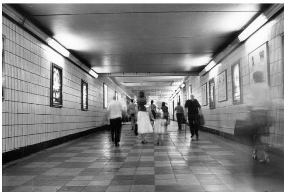
Zugang zu den Gleisen vor der Sanierung
