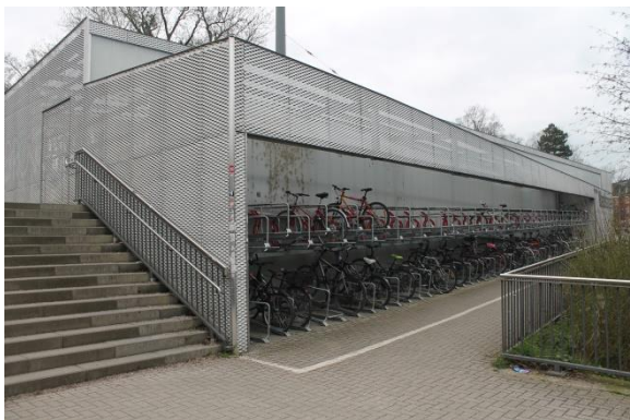
Blick von der Rettungsbrücke des Bahnhofs über den Flutgraben auf die Nordseite “Radhaus Süd” – 2021
