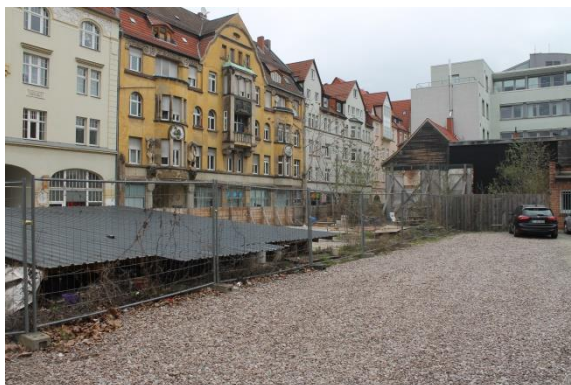
fehlende Block und Raumkanten nach Substanzverlust im Bereich der Schmidstedter Straße / Blick vom Grundstück über die Baulücke
