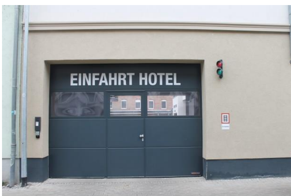
Gemäß der Sanierungszielstellung wurde die Hotelzufahrt in der Sonntagsgasse aufgegeben und in den Neubau der Thomasstraße integriert.
