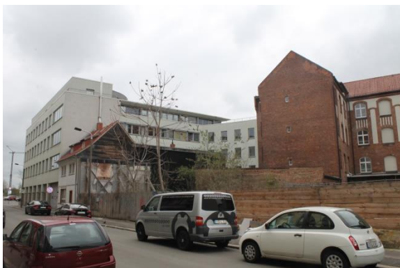
fehlende Block und Raumkanten nach Substanzverlust im Bereich der Schmidstedter Straße Straßenansicht
