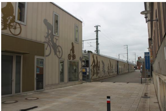
Blick von der Bahnhofstraße nach Westen auf die Nordfassade „Radhaus Nord“ – 2021
