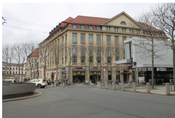
Blick vom IC-Hotel auf den sanierten und umgebauten ehemaligen „Erfurter Hof“
