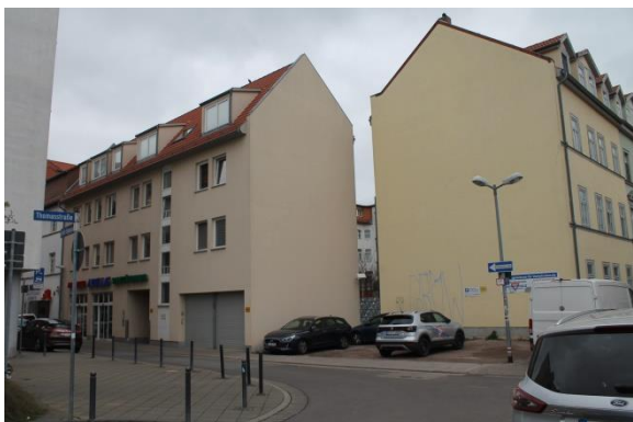
Ein Teil der ehemaligen Baulücke in der Ernstengasse konnte mit dem Neubau eines Wohn- und Geschäftshauses geschlossen werden.
