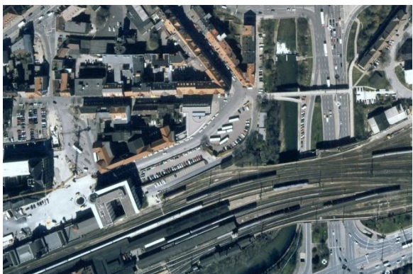
Luftbild der Kurt-Schumacher-Straße vor Sanierungsbeginn
