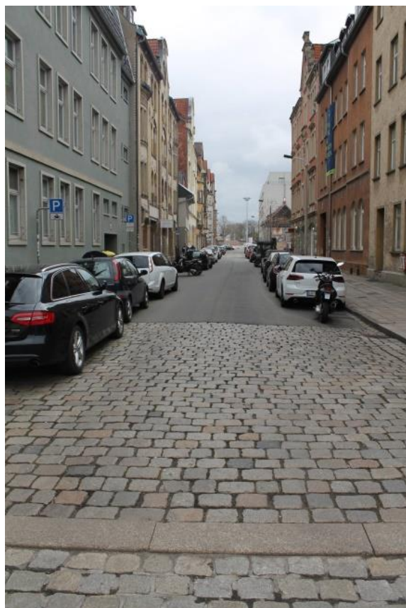
Unzureichende Qualität der Hauptanbindung der ICE City Ost an das Bahnhofsquartier / gestalterische und baulich mangelhafter Gesamtzustand der Schmidtstedter Straße
