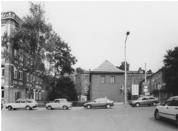
Blick über den Bergstrom an der LEG vorbei (links) nach Norden vor der Umstrukturierung.
