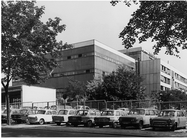
Optima-Gebäude vor Sanierung und Umbau / 01
