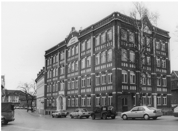
Blick nach Südwesten in die Mainzerhofstraße auf das Gebäude der LEG / noch vor Um- und Neubau der Straße bzw. Gleistrasse der EVAG.
