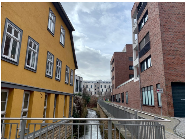
Blick nach Westen über den Bergstrom mit sanierter Altbausubstanz und Neubebauung entlang des Bergstroms.
