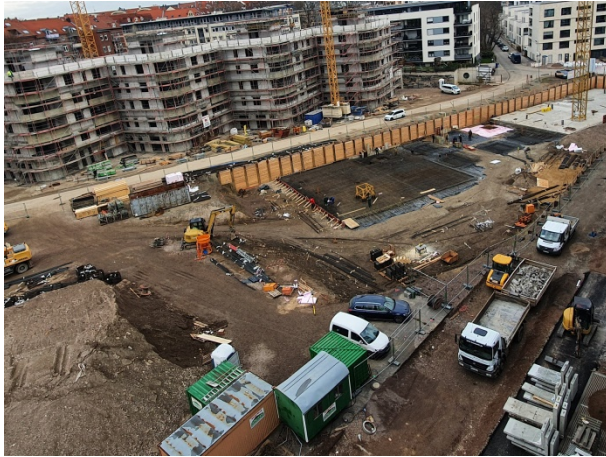
Blick nach Westen in die Baugrube des Neubauvorhabens BRV 710 – 26.11.2020.
