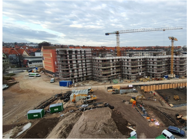
Blick nach Westen auf die benachbarte Neubebauung BRV 493 – 26.11.2020.
