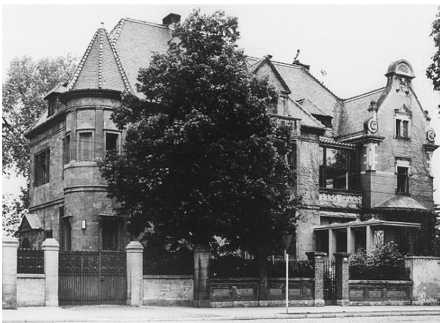
"Große" Villa Benary vor der Sanierung / heute ist die Villa komplett saniert und denkmalgeschützt.
