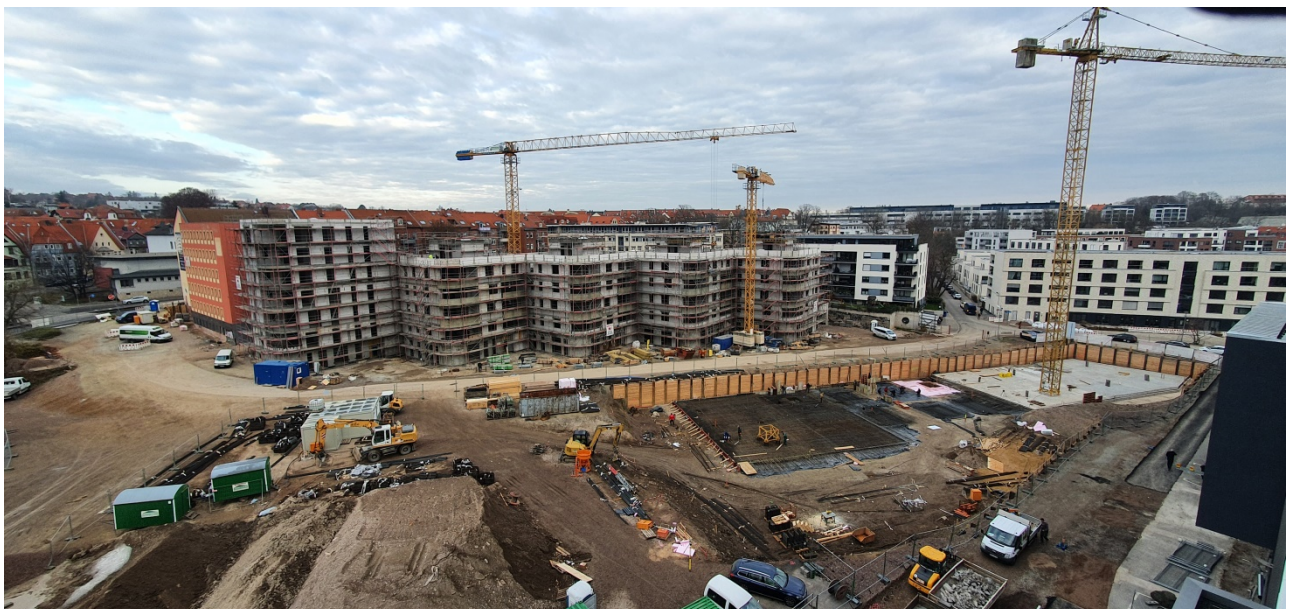
Blick nach Westen über das Baufeld des Bebauungsplans "BRV 710" auf den neuen sägezahnartigen Block und die Raumkante an der neuen Warsbergstraße.
