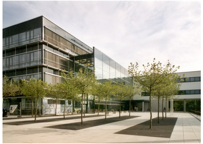
Optima-Gebäude nach Umbau zum Justizzentrum / 01
