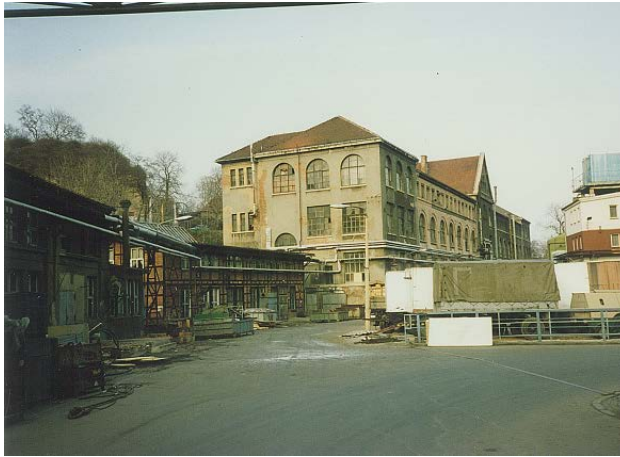
Blick auf den verbauten Südhang der Zitadelle Petersberg / Zugang zur Bastion Martin zu Beginn der 1990er Jahre.
