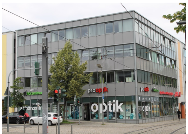
Blick vom Meinzerhofplatz nach Nord-Osten auf das Ärztehaus.
