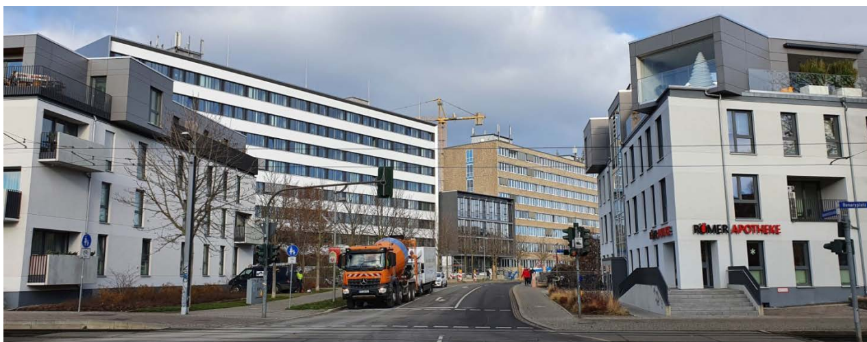
Blick vom Benaryplatz in die Bonemilchstraße auf das z.T. ausgebaut Technische Rathaus Warsbergstraße 3.
