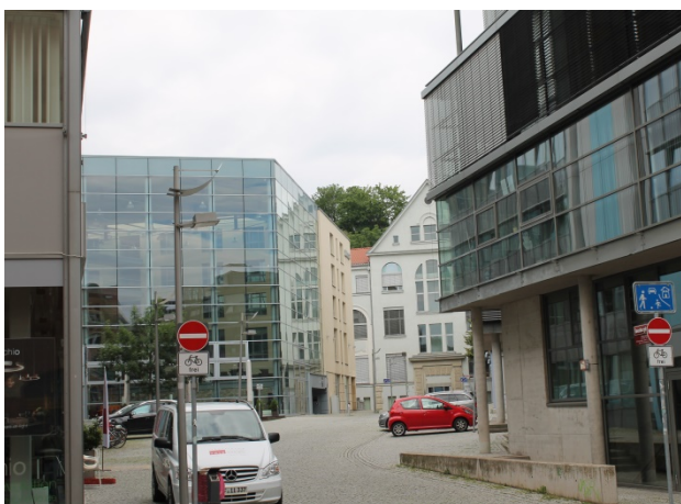
Blick in das neue Quartier über die Koenbergstraße nach Norden auf die sanierte ehemalige Gewerfabrik.
