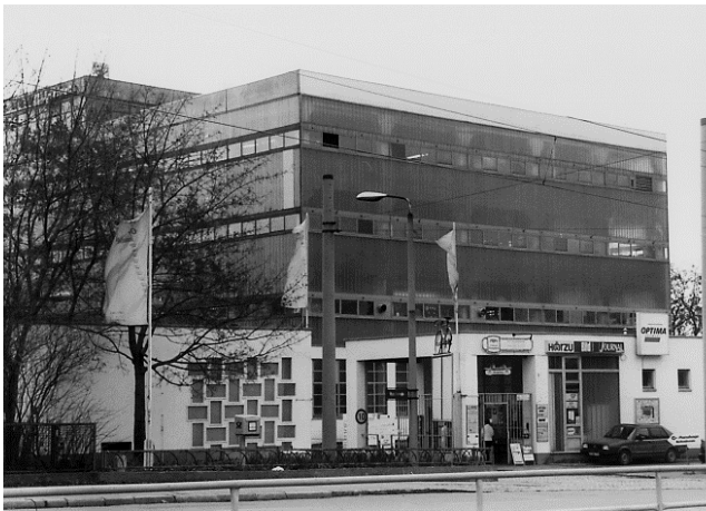
Optima-Gebäude vor Sanierung und Umbau / 02
