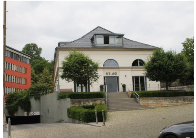
Kanonenschuppen nach umfassenden Sanierungs- und Umbaumaßnahmen / Peterstraße als verkehrsberuhigter, für den Durchgangsverkehr gesperrter und hochwertig ausgebauter öffentlicher Platz.
