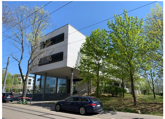
Optima-Gebäude nach Umbau zum Justizzentrum / 02
