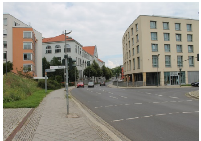
Blick nach Osten über die Maximilian-Welsch-Straße nach umfangreichen Sanierungs- und Neubaumaßnahmen 2020.
