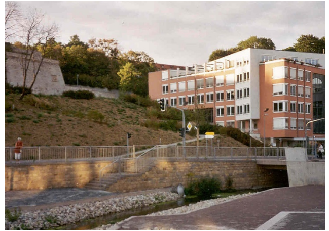
Freigestellter Zugang zur Bastion Martin nach baulicher Neufassung der Ostseite.
