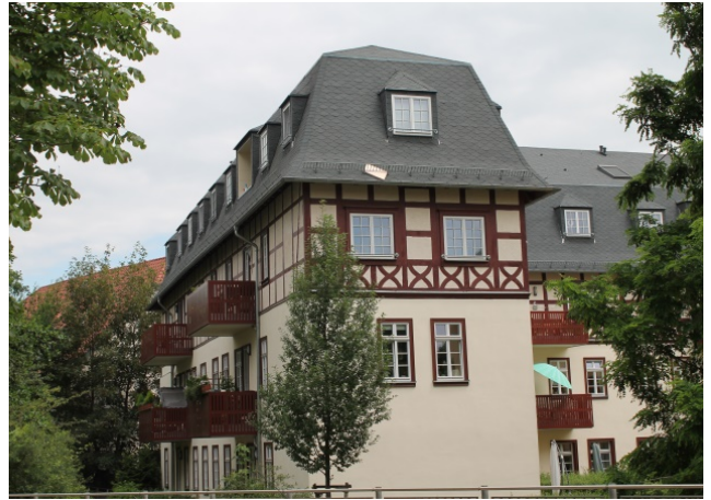
Saniertes und denkmalgeschütztes Bestandsgebäude.
