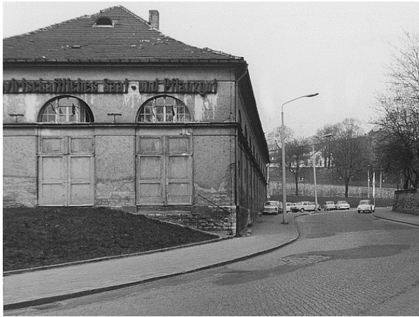
Ehemaliger Kanonenschuppen vor der Sanierung und die Peterstraße als "normale" Straße.
