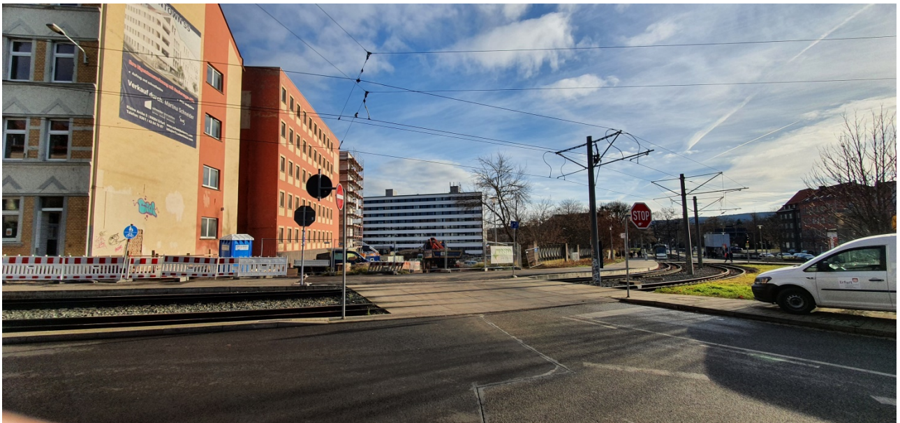
Blick vom Gothaer Platz auf das Baufeld des einschließlich der Verkehrsanbindung zur Warsbergstraße.
