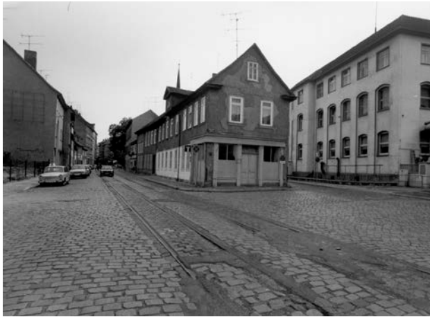
Blick in die Brühler Straße und Martinsgasse vor Beginn der Sanierungsmaßnahmen.
