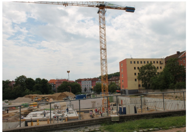
Blick nach Süden über das Baufeld der Tiefgarage in Richtung Gothaer Platz.
