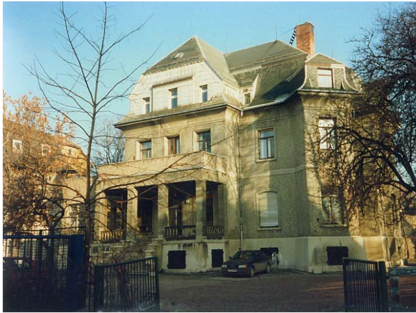
"Kleine" Villa Benary vor der Sanierung.
