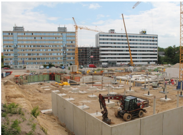
Blick nach Osten auf das neue Technische Rathaus in der Warsbergstraße.
