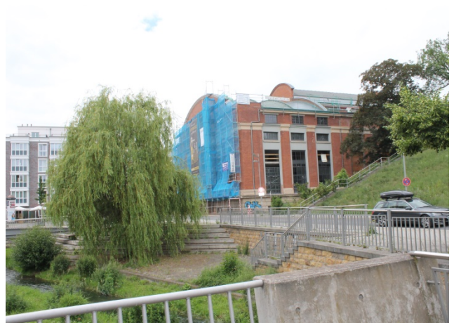
Neu / Blick nach Westen über den freigelegten und begrüntem Bergstrom.
