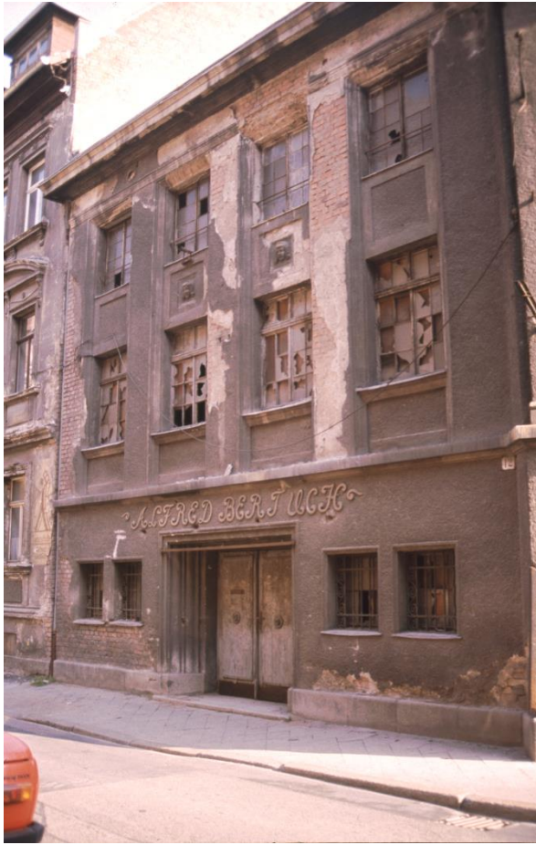
Das die Marstallstraße Zustand vor und nach der Sanierung
