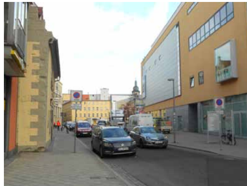
2013 Hirschlachufer - Blick aus Ecke Lachsgasse Neubau Geschäfts- und Parkhaus 'F1'
