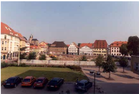
1999 Hirschgarten - Blick aus Richtung ehem. Löbertor Brachfläche nach Abbruch der Bauruine.
