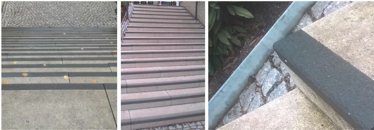
Abbildung 6: Stufenkantenmarkierung an Treppenanlage Mikwe
