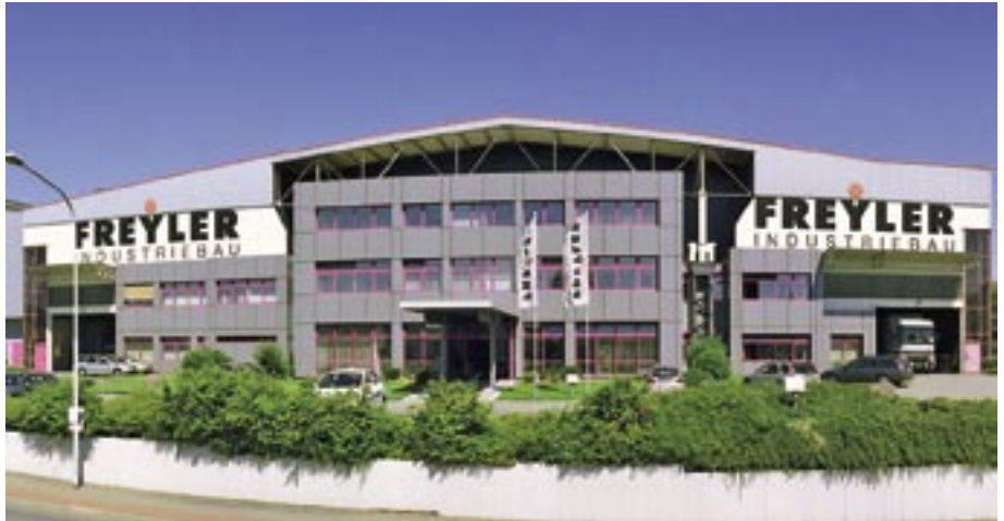
Der Firmensitz der FREYLER Industriebau GmbH in Riesa mit 14.000 Quadratmetern Produktionsfläche.
