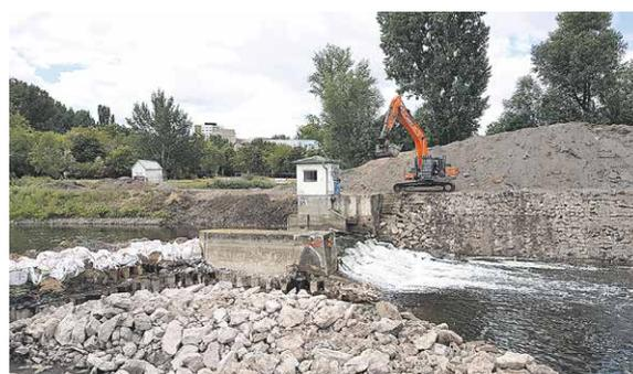
beträgt jeweils 13 Zentimeter. Zwischen ihnen fließt der Fluss serpentinartig hindurch – fast wie ein Wildbach – und überwindet so nach und nach eine Gesamthöhe von zwei Metern. Dabei liegt die Fließgeschwindigkeit unter zwei Metern pro Sekunde.
