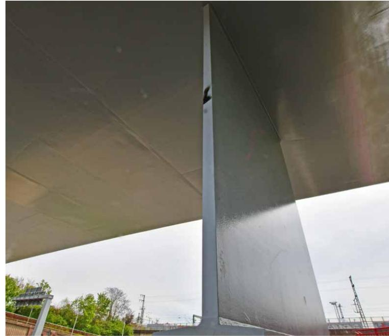
*Oben: Die Stützscheiben sind nur 80 Millimeter dick.*
