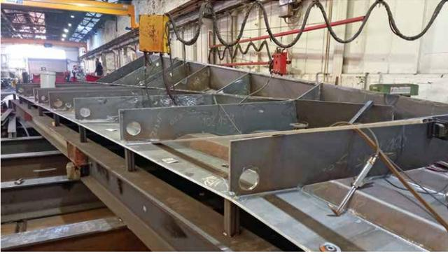
Überbau des kurzen Brückennastes ohne Deckblech mit Ansatz des Treppendecks.
