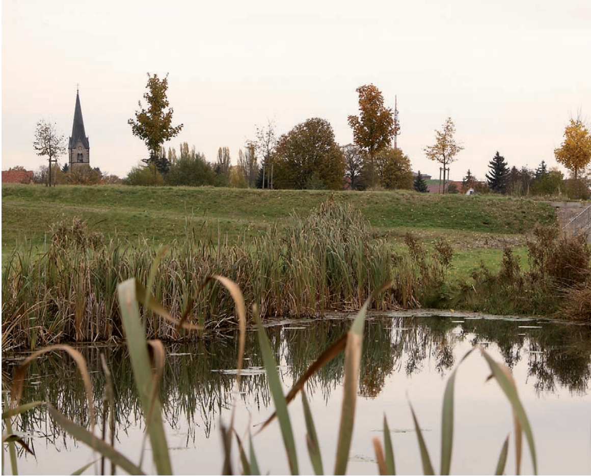
Eine der ersten Maßnahmen im Rahmen der Dorferneuerung in Schmira: der Bau des Regenrückhaltebeckens am Bettelseegraben
