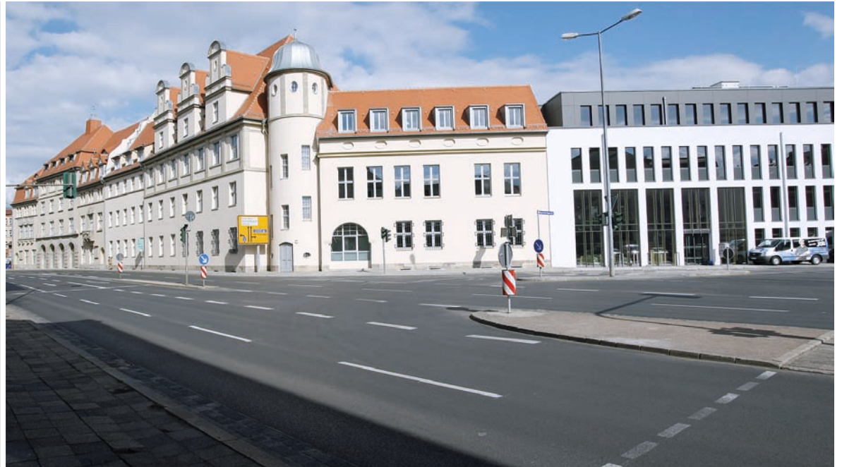
Kernstück des neuen Verwaltungsgebäudes ist die alte Feuerwache am Juri-Gagarin-Ring, daneben befindet sich der Neubau.
