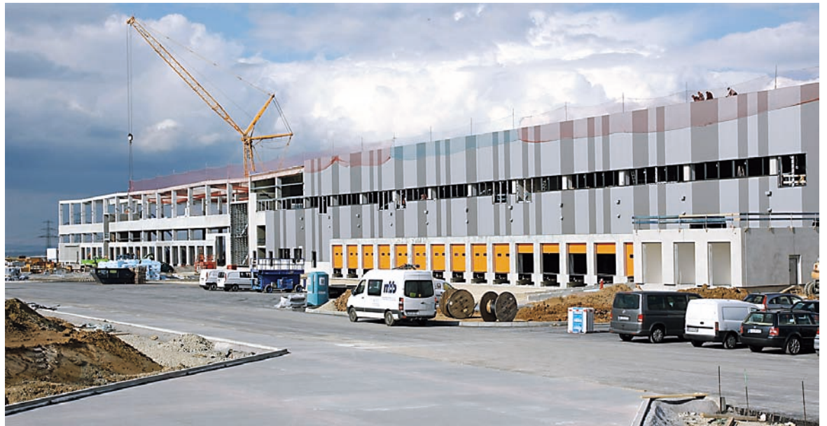
Die Lagerhallen 1–3 von Zalando im Güterverkehrszentrum nehmen Kontur an.
