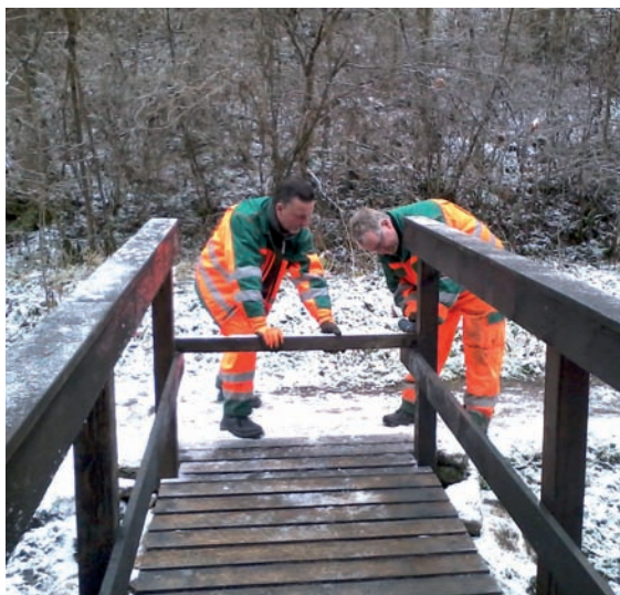
Hans-Jürgen Voigt und Jürgen Weigel, Bundesfreiwillige Mitarbeiter im Umwelt- und Naturschutzamt, entfernen die letzte Barriere und geben die Brücke für den Fußgängerverkehr frei. ■
