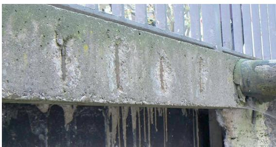
Das Brückengesims am Geländer mit korrodierter Bewehrung.
