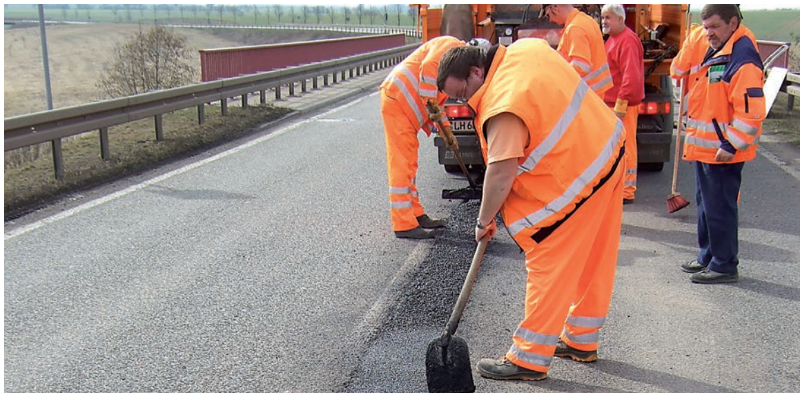
Das Verfüllen von plötzlich auftretenden Schlaglöchern mit Asphalt gehört zu den Aufgaben der Straßenbauer.
