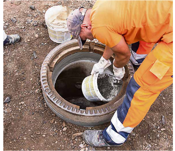
Die Mitarbeiter der Kanalinstandhaltung kommen bei 25.000 Deckeln nie zur Ruhe.
