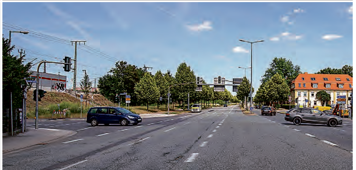
Die Weimarische Straße erhält ab 13. August vom „Schwarzen Loch“ bis zum Dittelstedter Weg eine neue Fahrbahndecke.
