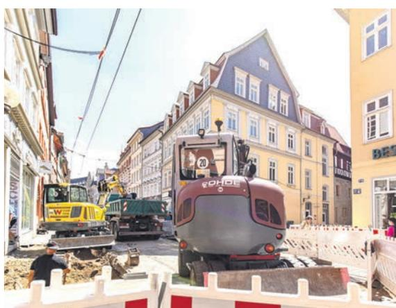
Stadtwerke wollten nur die Hausanschlüsse erneuern, jetzt wird die komplette Gasleitung getauscht. Zum anderen lag im Eingangsbereich der Marktstraße vom Fischmarkt aus kommend die Decke des Gewölbekellers so hoch unter dem Belag, dass dafür erst eine ingenieurtechnische Lösung gefunden werden musste, für deren Planung und technische Umsetzung wertvolle Zeit verging.“
