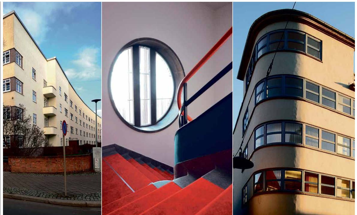
Beispiele der Bauweise: Hamburger Block, der KKH-Isolierpavillon von Innen sowie das Haus Schellhorn, Neuwerkstraße 2 (v. li.)
