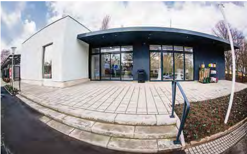
Das neue Besucherzentrum gleich neben dem Haupteingang wurde an das bestehende Gebäude angebaut.
