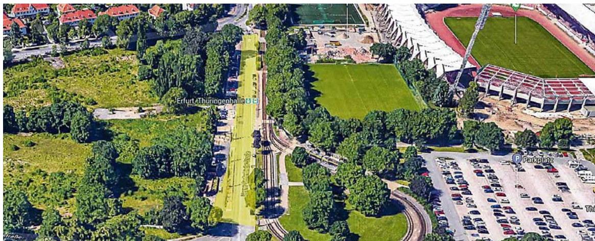
Mit der Sanierung der Arnstädter Straße soll im Herbst begonnen werden.
