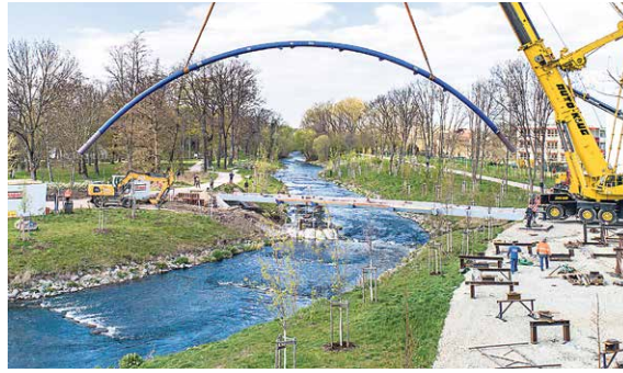
... kam der Brückenbogen an den Kran.
