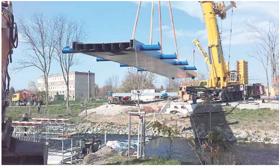
Nachdem das Brückendeck eingehoben wurde ...
