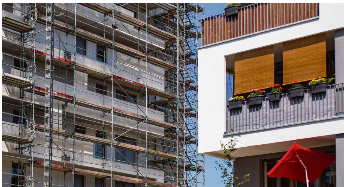
In Erfurt sind aktuell tausende Wohnungen in Planung, Bau und Vorbereitung. Hiervon sollen künftig 20 Prozent an mietpreis- und belegungsgebundenem Wohnraum entstehen.
