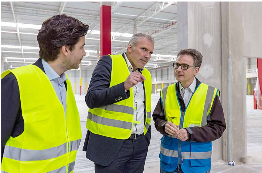
Philipp Pferschy, Vorstand der GIEAG AG, OB Andreas Bausewein und Bernd Gschaider (v.l.n.r.) von Amazon Logistics beim Baustellenbesuch.
