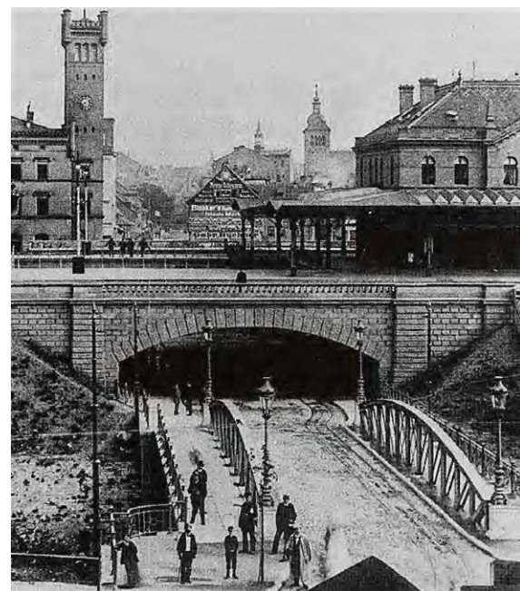
Als erste Stahlfachwerkbrücke Erfurts überspannte die heutige „Riethbrücke“ ab 1890 den Flutgraben hinter dem Bahnhof. © Stadtarchiv Erfurt
