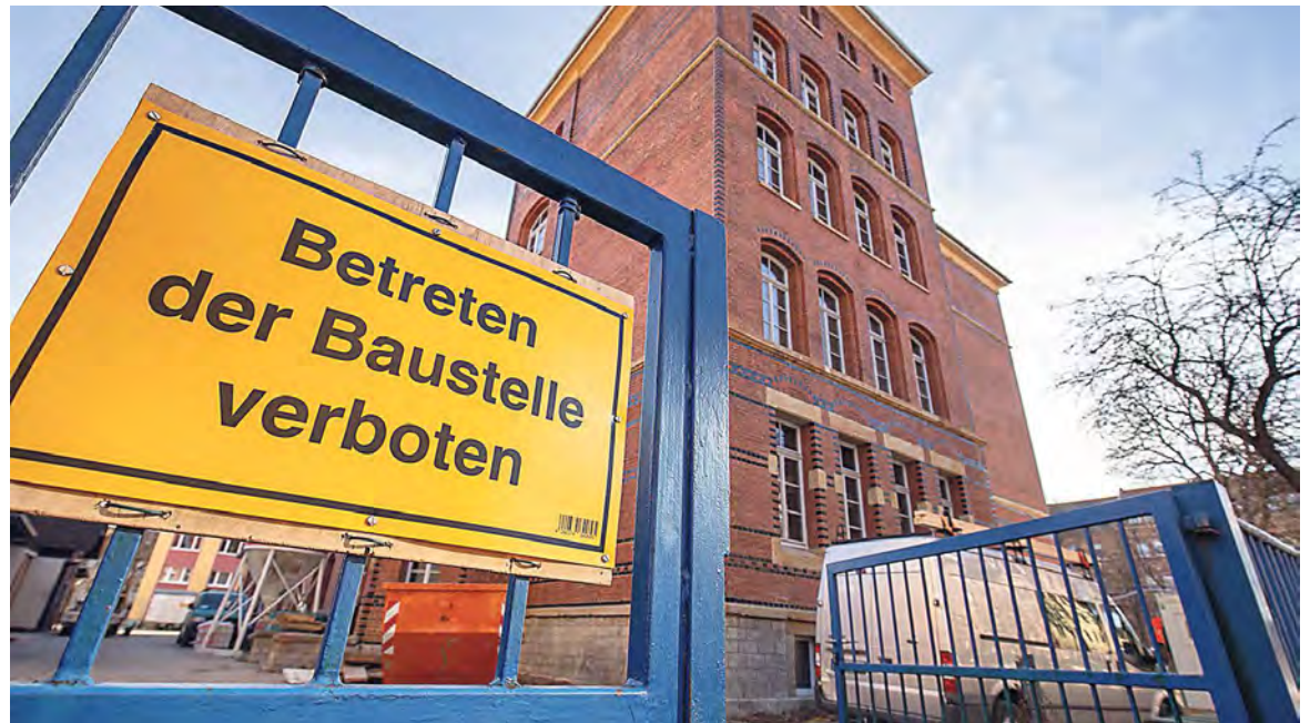
Die Grundschule an der Rosa-Luxemburg-Straße wird generalsaniert, die Kinder fahren jeden Morgen in ein Ausweichobjekt.
