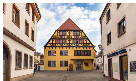
Im „Haus zum Sonneborn“ befindet sich heute das Standesamt.
