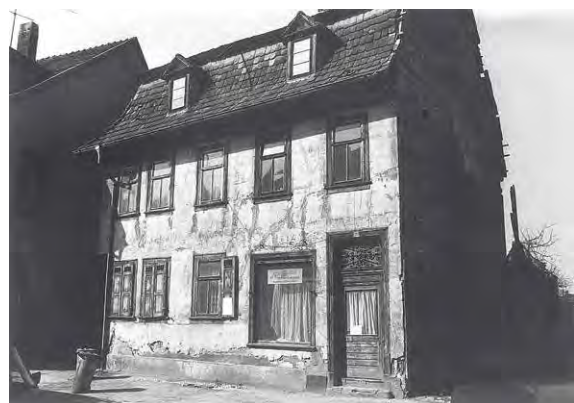
Bestandgefährdetes Haus in der Pergamentergasse 1990: Heute sieht die Straße wieder prachtvoll aus. ■
