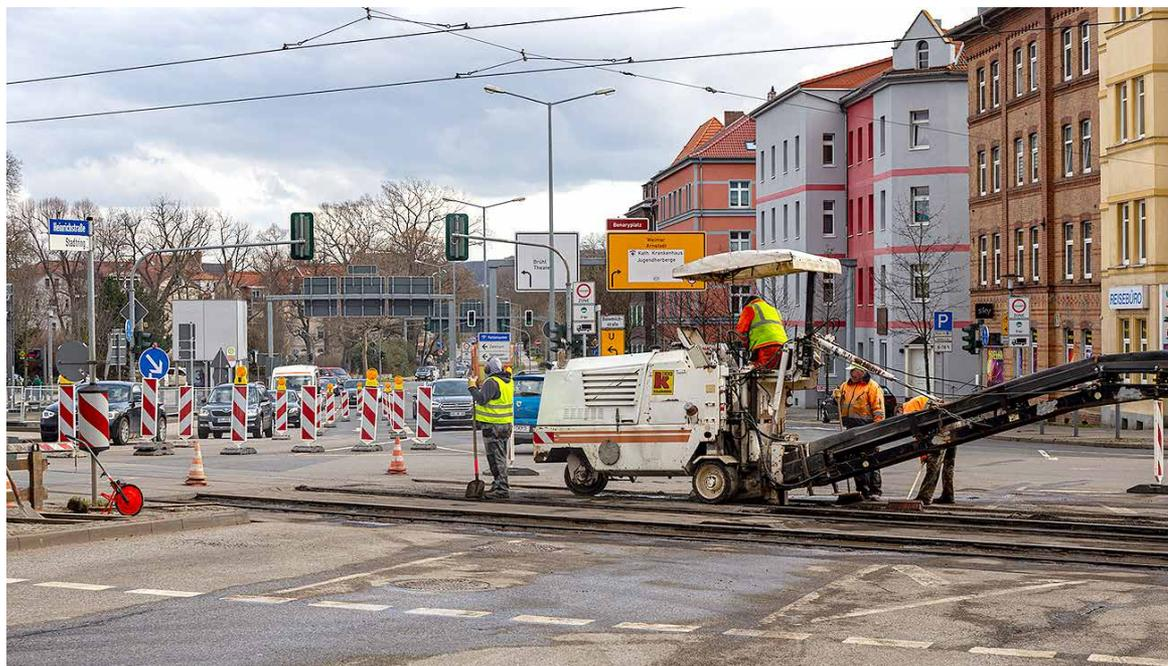
Am Gothaer Platz wird derzeit der Asphalt im Gleisbereich erneuert. Geplanter Termin der Fertigstellung ist der 20. März.
