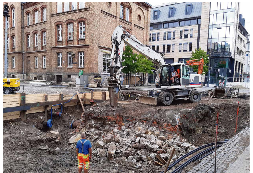
Sonntag, 02.08.2020: Die Gleise sind weg, der Bagger gräbt sich durch das Gestein der Tunnelröhre, in der die abgeklemmten Trinkwasserleitungen verlaufen.
