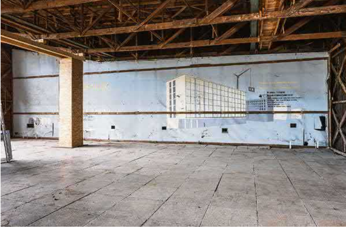
Beim Entkernen von Halle 3 tauchte ein Wandkunstwerk auf.
