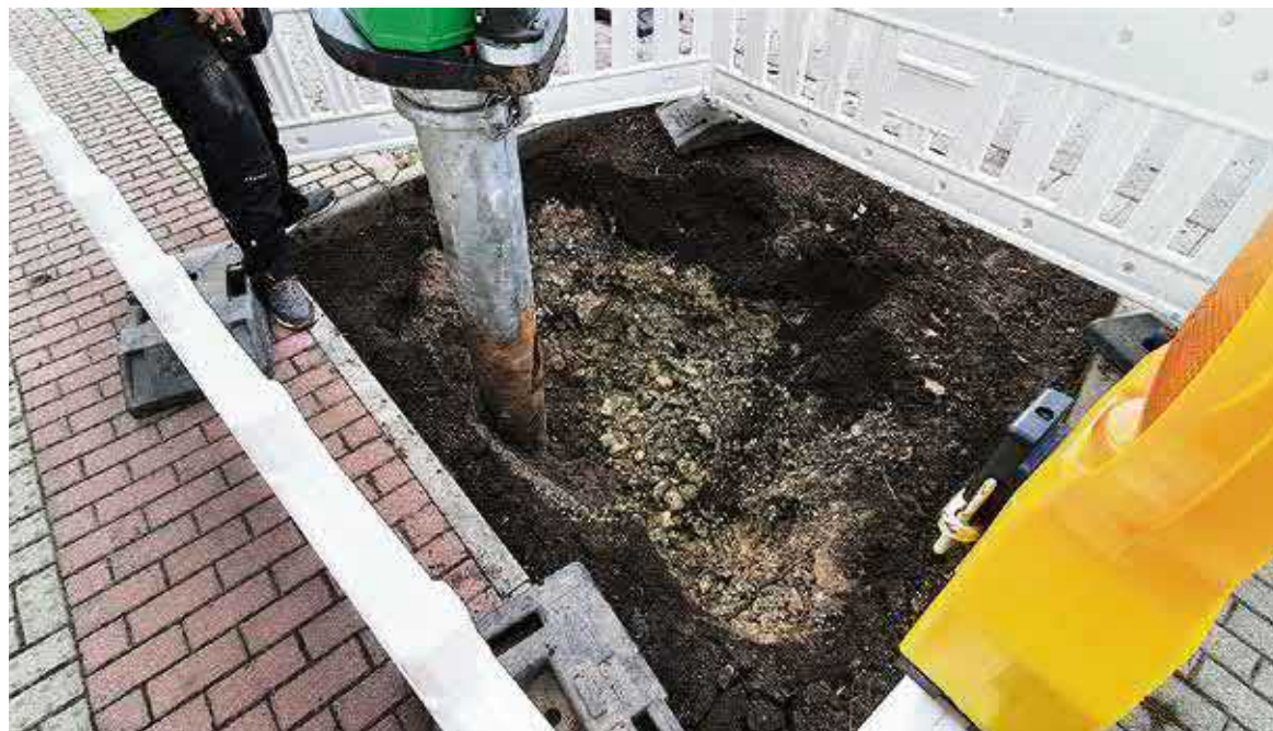
Der Saugbagger in der Iderhoffstraße im Einsatz. Hier wurden mehrere Groß- und Kleinsträucher sowie zwei Bäume gepflanzt.
