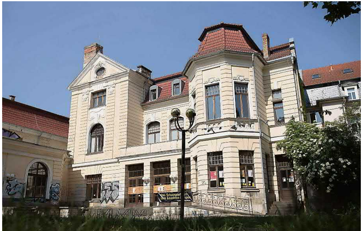
Das markante Gebäude im Kloostergang bleibt der Kultur erhalten und hat wieder eine Zukunft.
