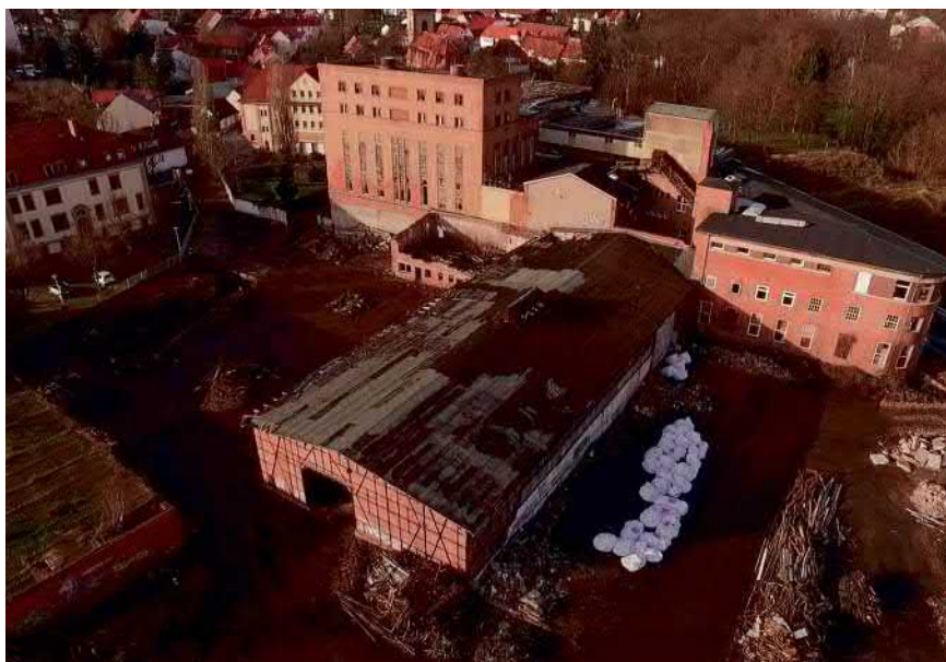
Das Gisperslebener Heizkraftwerk kurz vor seinem Abriss 2015 © SWE Stadtwerke Erfurt GmbH
