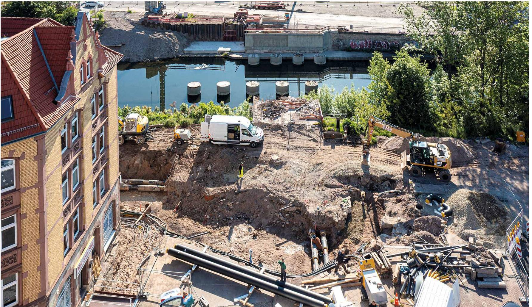
Baubericht zum Promenadendeck: Alle Arbeiten liegen im Zeitplan und die Baustelle wird für die Ankunft der vorgefertigten Brückensegmente vorbereitet. Zu erkennen sind auf dem Bild die zum Teil fertiggestellten Widerlager der neuen Brücke am östlichen Ufer des Flutgrabens. Im Flutgraben ragen die Fundamente für die Hilfsstützen aus dem Wasser. Bevor die einzelnen Segmente aus dem Stahlwerk in Hannover nach Erfurt kommen und das neue Promenadendeck auf der Baustelle
