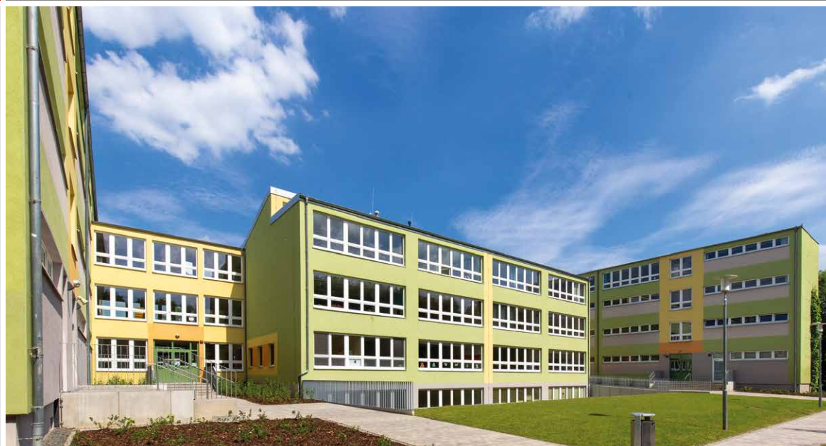
Der räumlichen Enge am Schulkomplex „Otto-Lilienthal“ in der Mittelhäuser Straße wird Abhilfe geschaffen. Eine Erweiterung mit neun Unterrichtsräumen ist auf den Weg gebracht.
