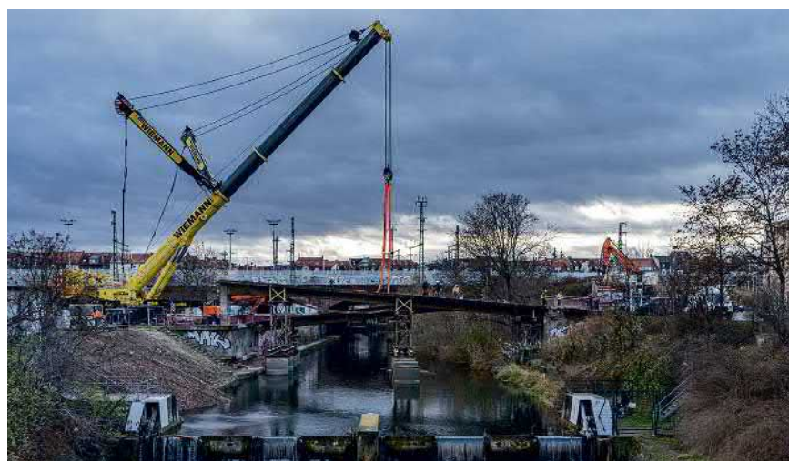
Allein Ausschreibung und Finanzierung waren eine Mammutaufgabe. Am Schmidtstedter Ufer entsteht das Promenadendeck.
