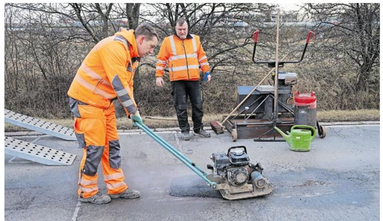
Eine Rüttelplatte verdichtet den Asphalt und das Schlagloch ist passé.
