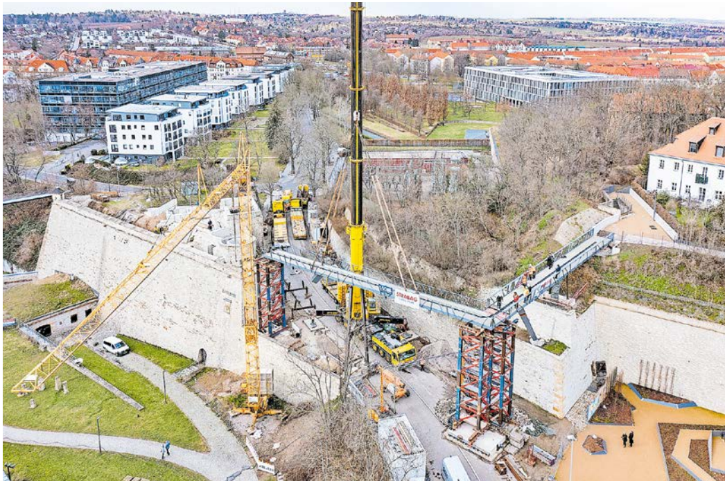
Im Februar wurde das größte Teil der Mauerkronebrücke eingehoben.
