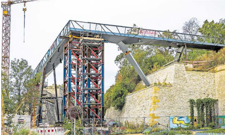
Die Mauerkronenbrücke am Lauentor wird die Festungsanlage wieder mit der Bastion Martin verbinden.
