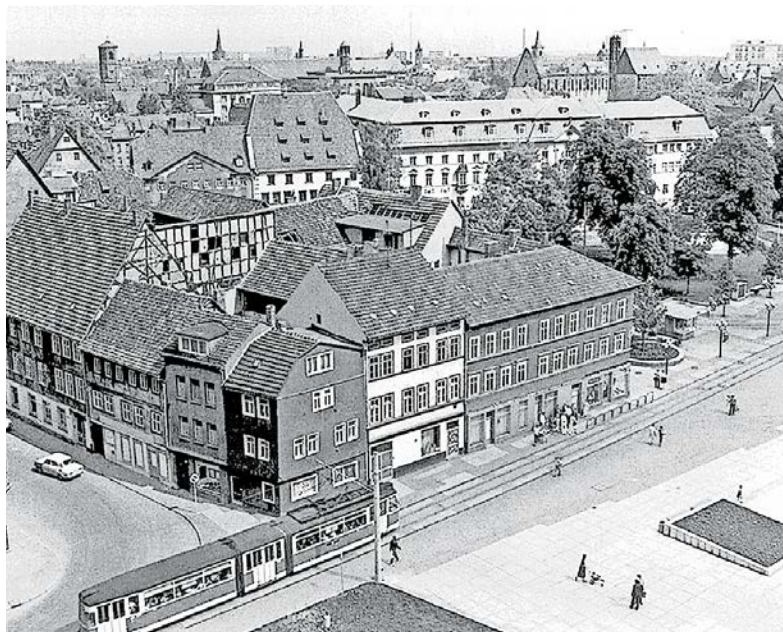
Altstadtquartier zwischen Eichenstraße und Regenbogengasse vor dem Abriss 1983
