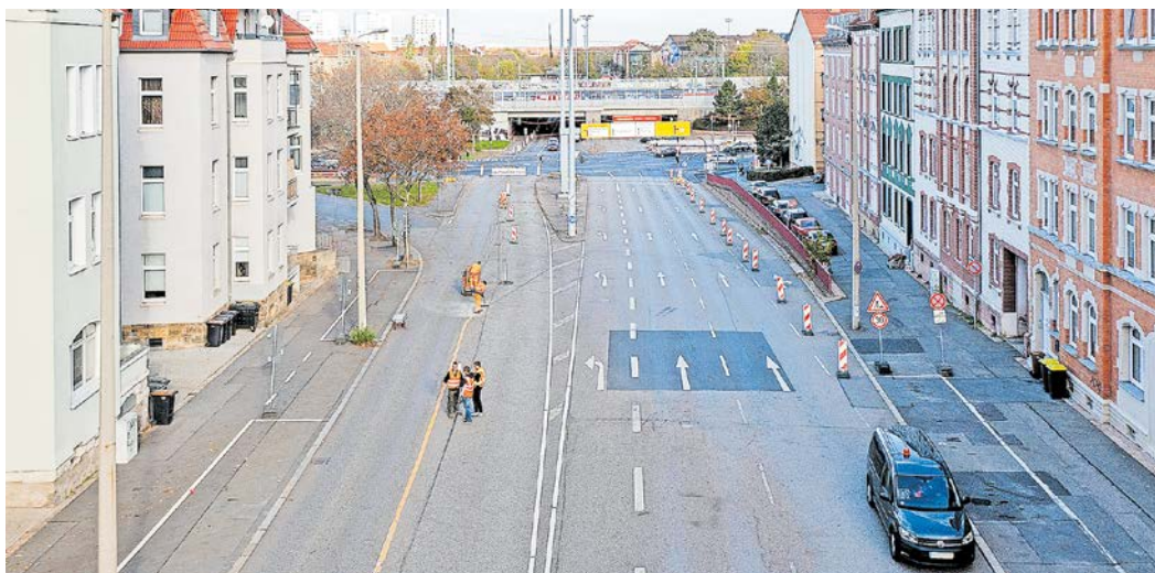
Seit Anfang November wird die Verkehrsführung in der Clara-Zetkin-Straße umgebaut.
