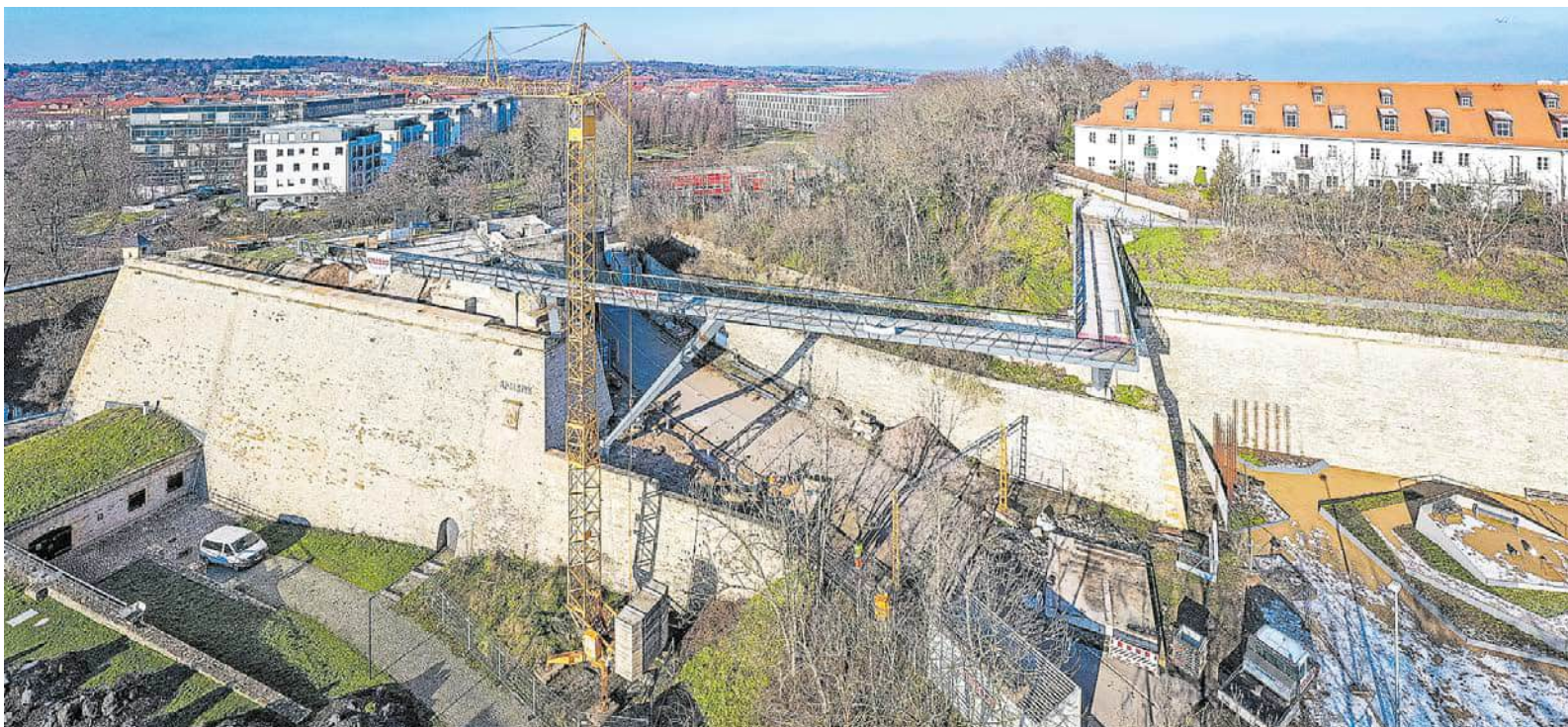
Wenn die Mauerkronenbrücke fertig ist, bietet sich von ihr ein toller Blick über die Stadt, zudem wird das Lauentor wieder geöffnet.
