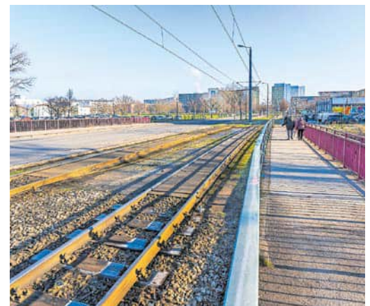
Der Brückenneubau in der Warschauer Straße wird durch die Gleise der Stadtbahn eine technische Herausforderung.
