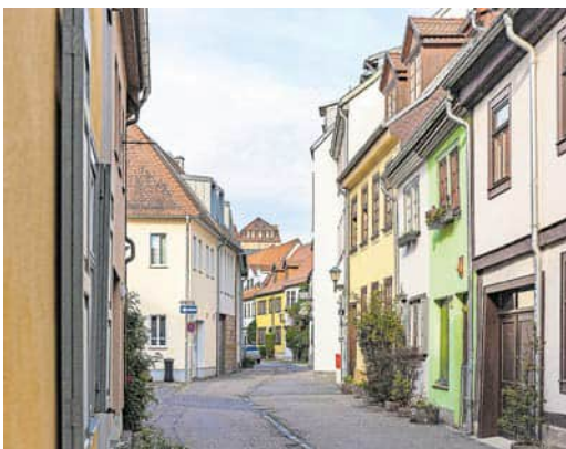
Mit diesen Arbeiten wird das Sanierungsgebiet „Andreasviertel“ abgeschlossen.
