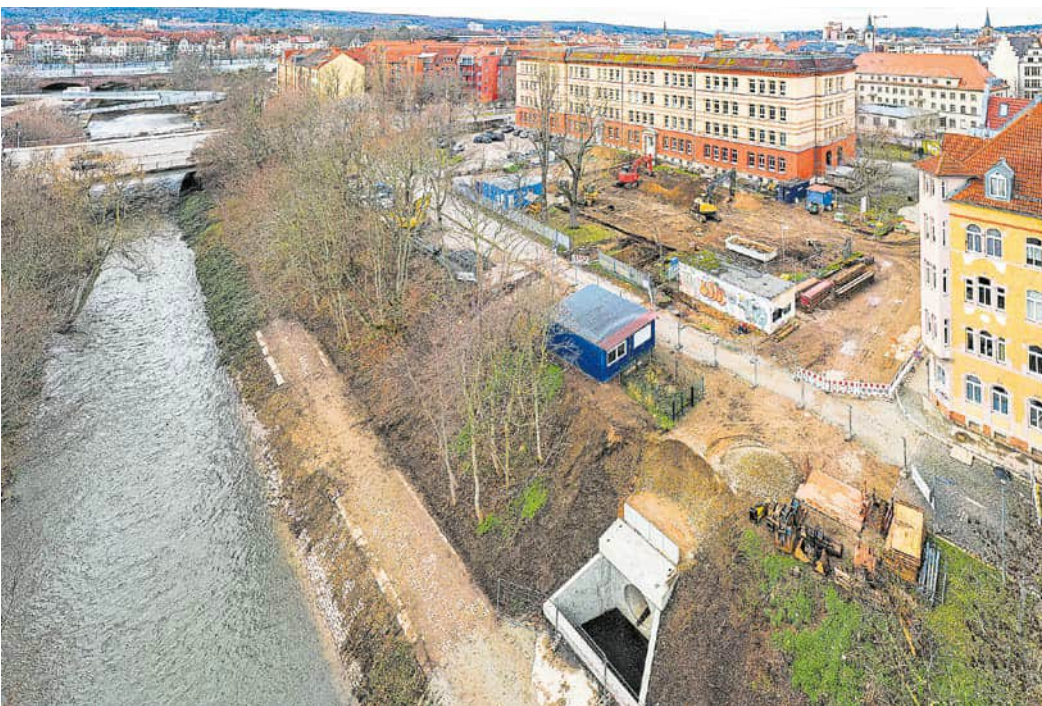
Auf dem Schulhof der Andreas-Gordon-Schule entsteht ab April ein weiteres Regenüberlaufbecken.
