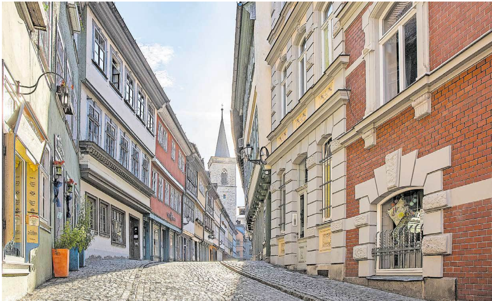
Das Wahrzeichen Erfurts – die Krämerbrücke. Die Erneuerung ihrer „verstaubten“ Elektrik soll Kabelbränden vorbeugen.
