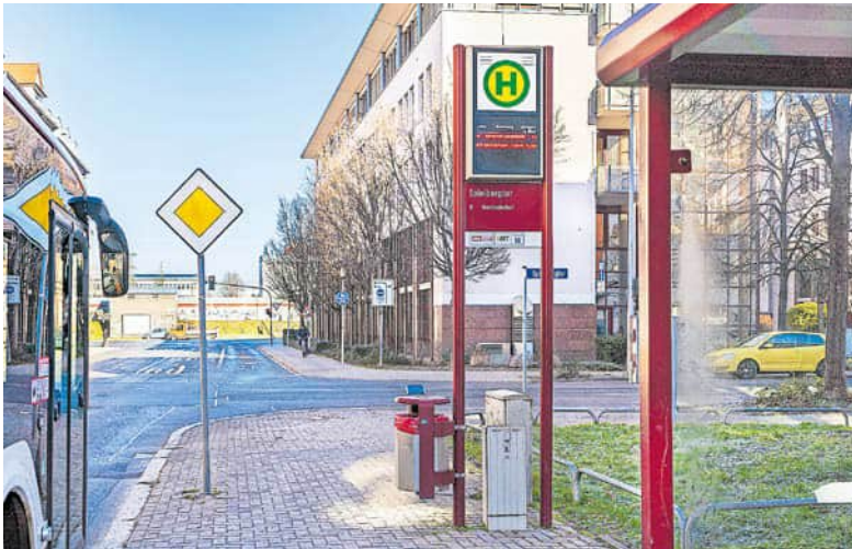
Rund ein halbes Jahr werden die Bauarbeiten in der Wilhelm-Busch-Straße dauern, danach ist die Bushaltestelle barrierefrei.
