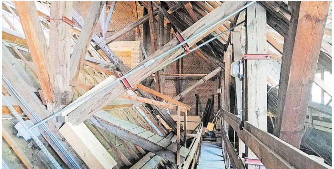
Zwei Knotenpunkte im Dachstuhl der Thüringenhalle wurden mit Stangen aus hochfestem Stahl gesichert. © Metallbau Loth
