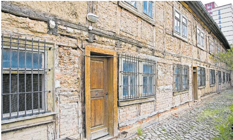
Die Fassade des Großen Pfründnerhauses im Jahr 2014: Das Gebäude hat insgesamt fünf Zugangstüren auf der Westseite. Jeweils vier Parteien nutzten einen Eingang. © Dirk Urban
