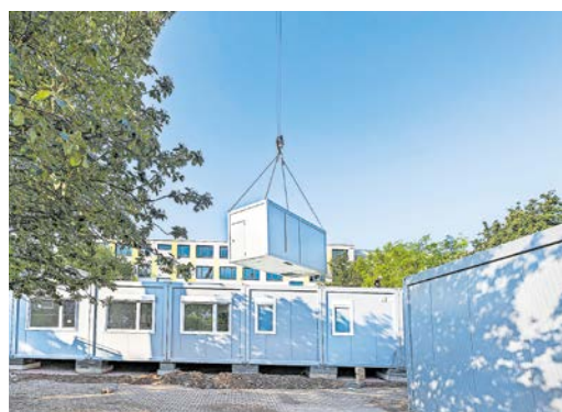
Mittels Kran wurden die Container von einem Tieflader auf das Schulgelände gehoben.
