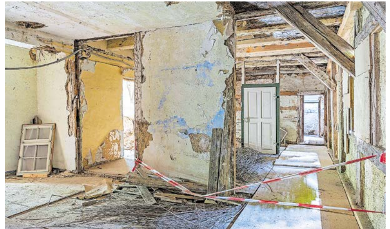
Eine aktuelle Innenaufnahme: Die Holzbalken stammen vermutlich aus dem 14. Jahrhundert, unter Schichten von Farbe und Putz kommt der Lehm zum Vorschein. © Dirk Urban
