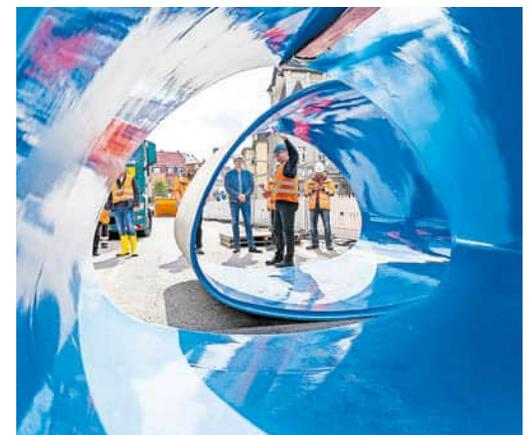
Spektakuläre Bilder bot 2021 die Sanierung des Schwemmbachkanals mit Modulen aus glasfaserverstärktem Kunststoff – für den Entwässerungsbetrieb eine nicht alltägliche Baumaßnahme.
